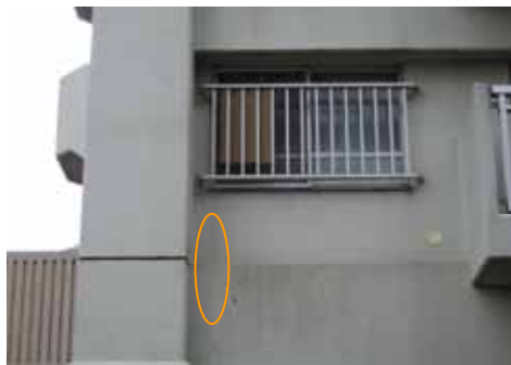
( 窓下の腰壁をカットした例 ) ( ピロティの花台を柱際でカットした例 ) ( 写真出典：既存共同住宅の多世代利用化に向けた改修及びマネジメント手法に関するマニュアル ( 案 ) )
