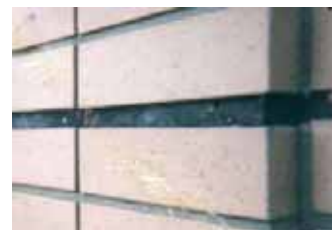
改修前のシーリング材
