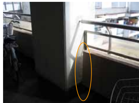
( 窓下の腰壁をカットした例 ) ( ピロティの花台を柱際でカットした例 ) ( 写真出典：既存共同住宅の多世代利用化に向けた改修及びマネジメント手法に関するマニュアル ( 案 ) )
