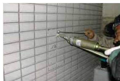
エポキシ樹脂の注入
