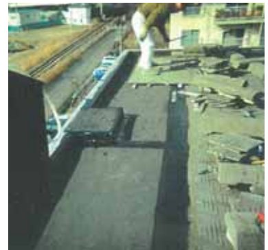
防水層の復旧
