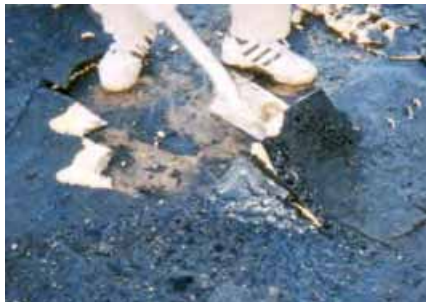
既存防水層の撤去
