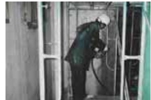
高圧水洗浄工法の例
