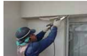
超音波ケレン工法の例
