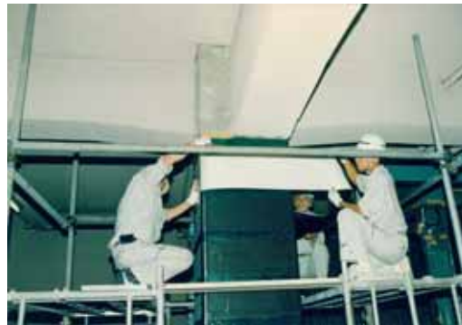
(炭素繊維巻き作業中)
