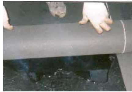
防水層の新設
